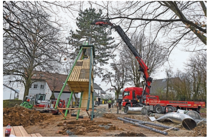
Der neue Spielurm wird mit dem Autokran aufgestellt
