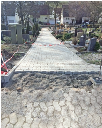
Die Arbeiten am Kleinheppacher Friedhof sind im vollen Gange
